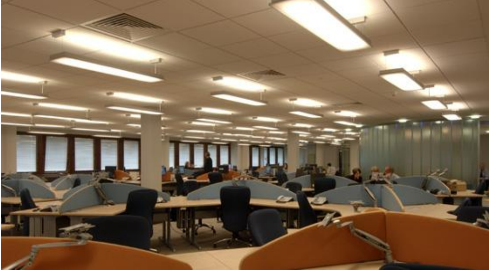
Resim 2.9: Ofis aydınlatma uygulaması
