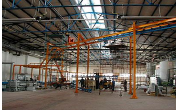
Resim 2.3: Fabrikalarda testere çatı uygulaması ve doğal aydınlatma uygulamaları
